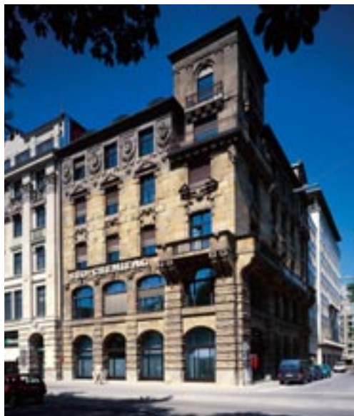
Die Konzernzentrale der Süd-Chemie AG in München, Lenbachplatz
